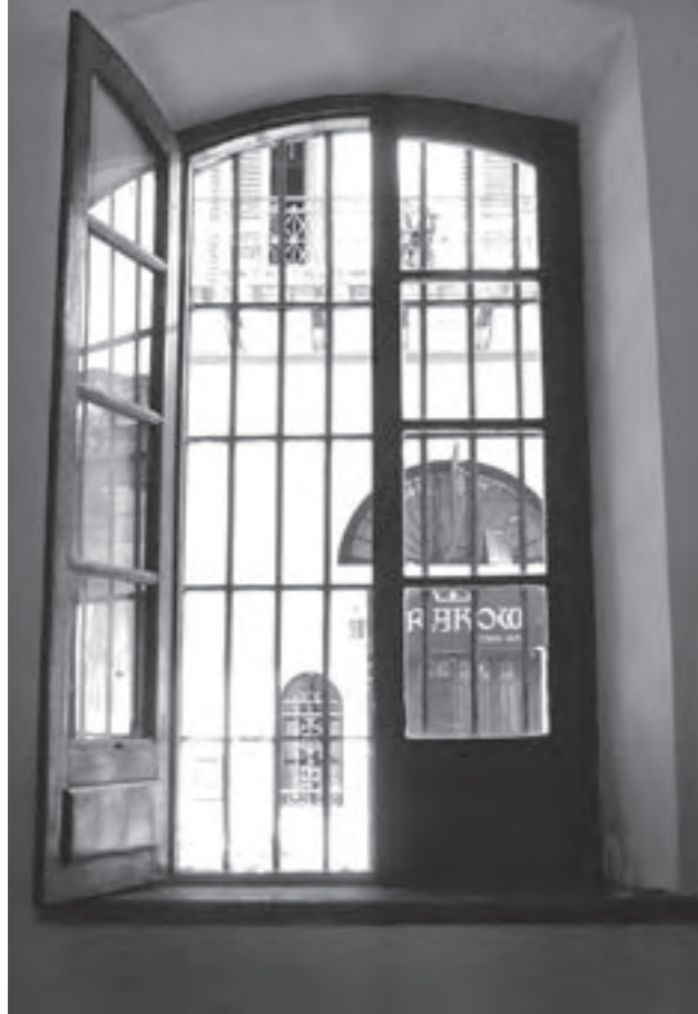
Ventanal de la Casa de Liniers
