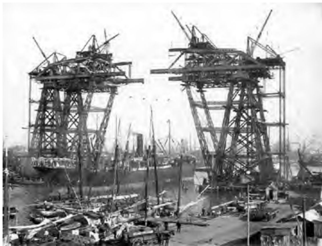
El transbordador aún en construcción (circa 1913)
